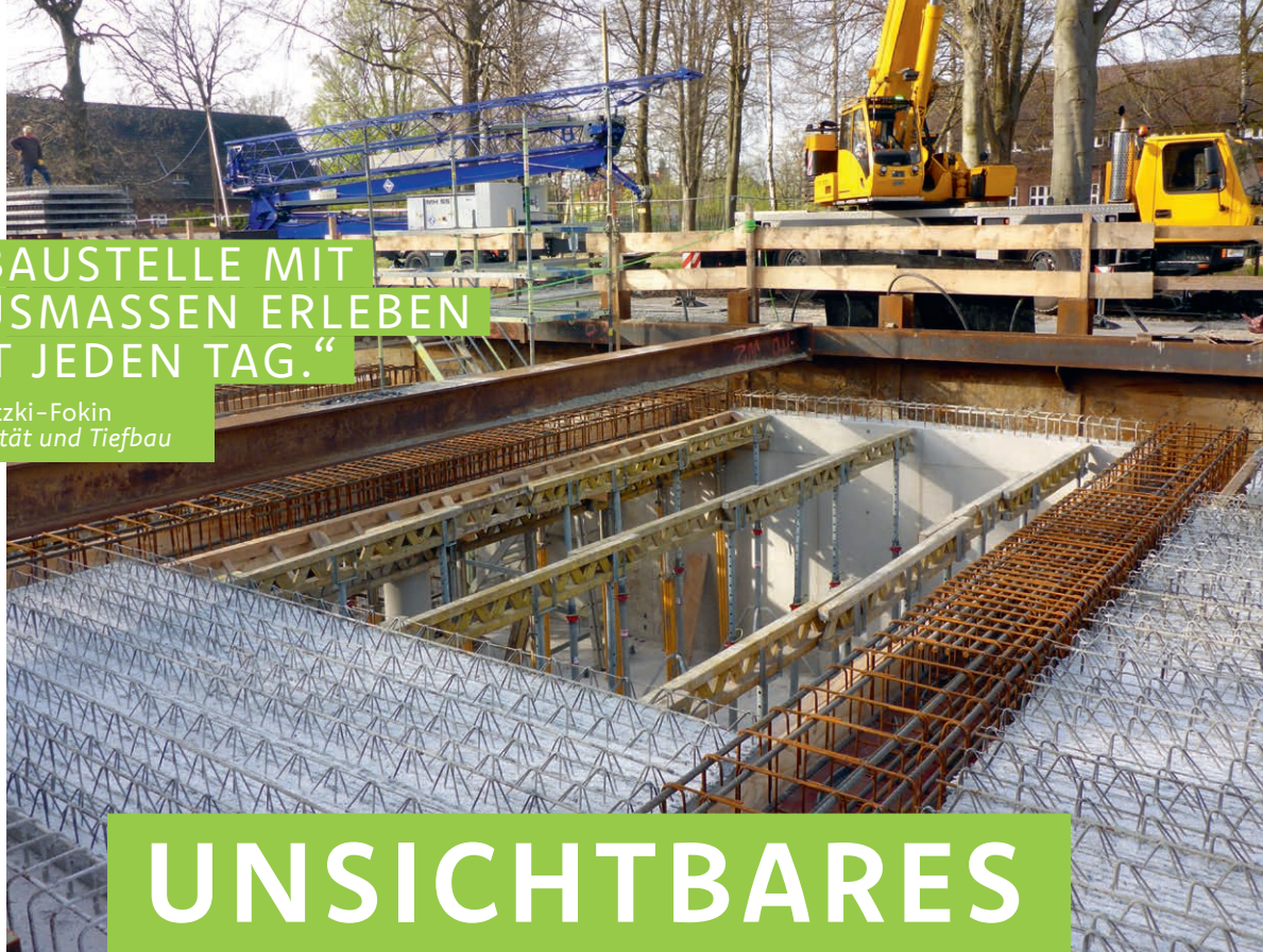
10 mal 40 Meter misst das unterirdische Regenrückhaltebecken.
