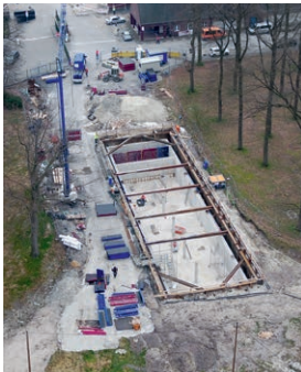
10 mal 40 Meter misst das unterirdische Regenrückhaltebecken.
